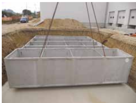
Realizzazione di impianto laminazione e trattamento prima pioggia
