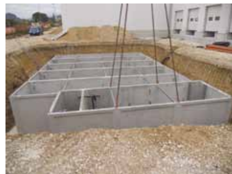
Realizzazione di impianto laminazione e trattamento prima pioggia
