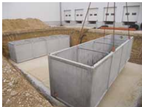
Realizzazione di impianto laminazione e trattamento prima pioggia
