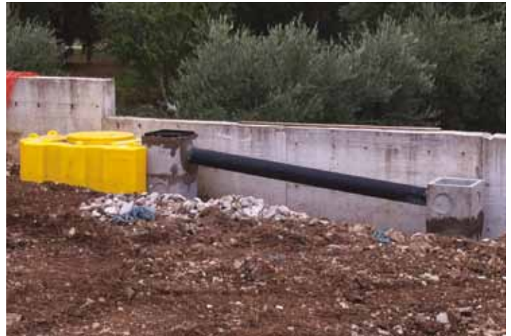
Separatori di coalescenza con raccolta fanghi SKPE 3/300, frantoio, Latina
