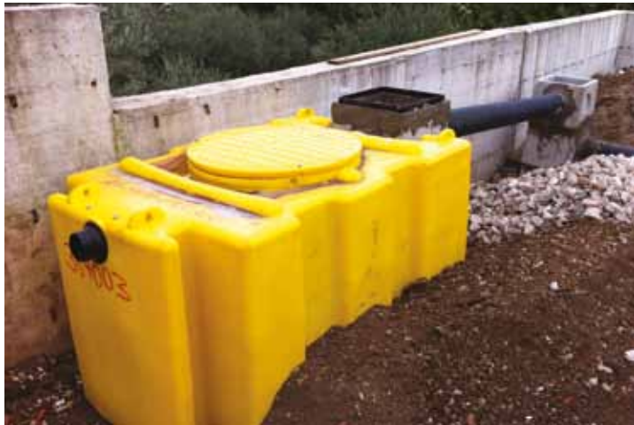
Separatori di coalescenza con raccolta fanghi SKPE 3/300, frantoio, Latina
